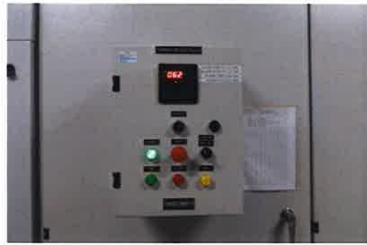
จอแสดงผลค่าอุณหภูมิหม้อแปลง
