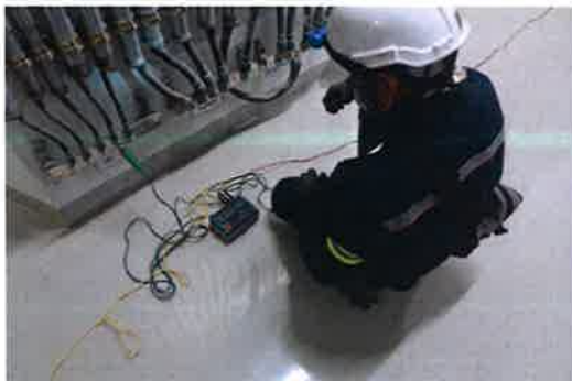
ตรวจวัดค่าความต้านทานดินหม้อแปลง
