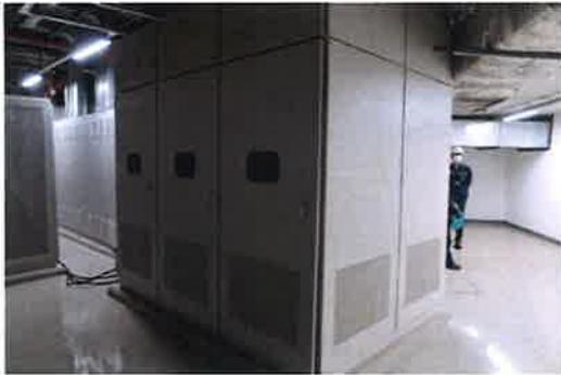
การตรวจสอบหม้อแปลง TR6 ขนาด 2000 kVA
