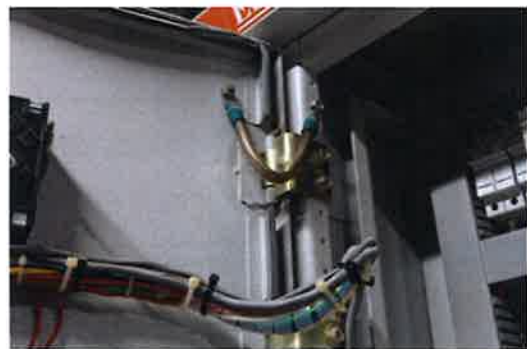
ตรวจสอบระบบสายกราวด์ฝากฟาสต์
