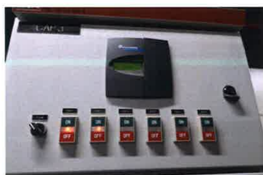
ระบบแสดงผล Capacitor Bank
