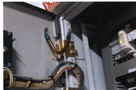
ตรวจสอบระบบสายกราวด์ฝากฟาดู
